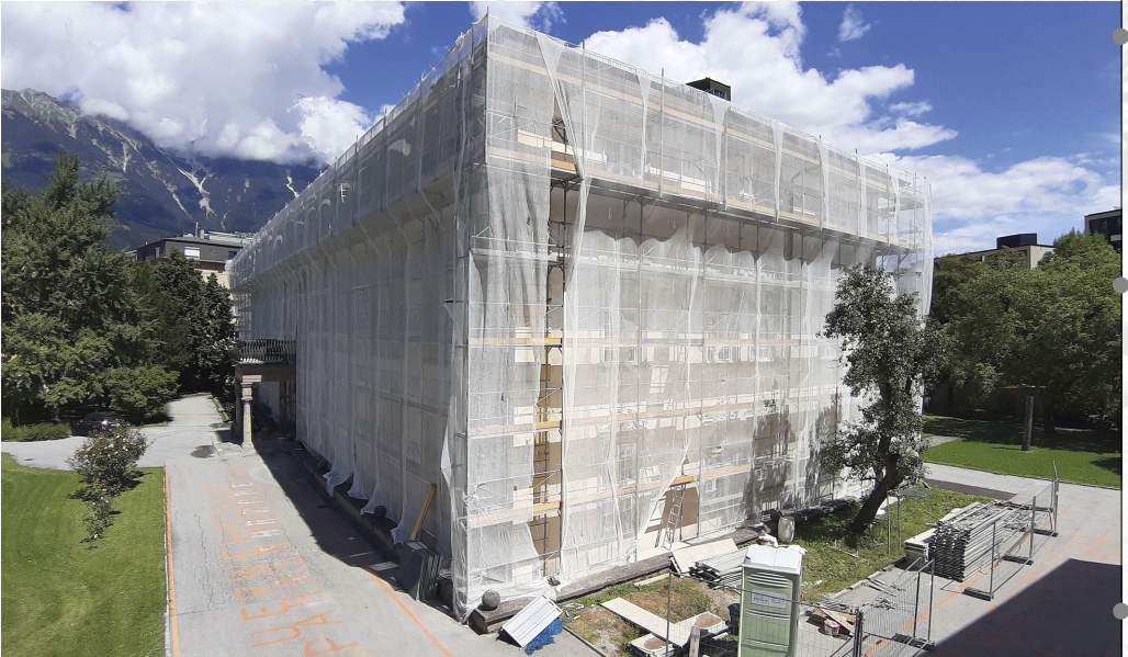
Sanierung der Fassade
