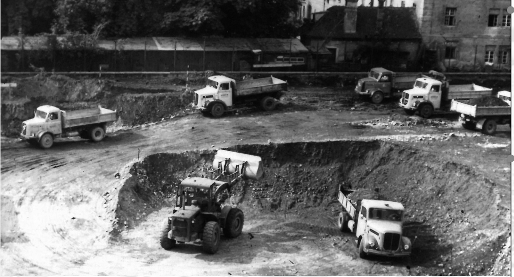
Baubeginn des Erweiterungsbaues 1968
