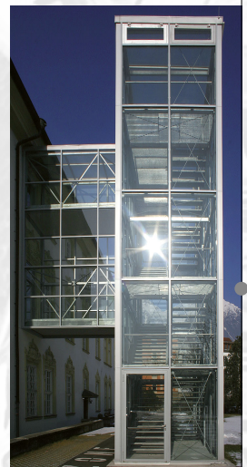
Feuertreppe Palais ostseitig
